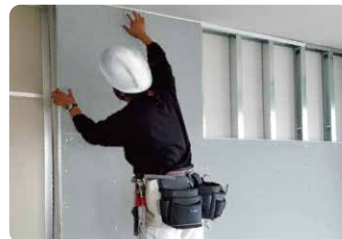
タイガーFeボードを施工(不陸調整・専用パテ含む)して
